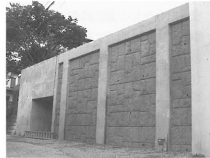
背面梁付擁壁の施工事例
