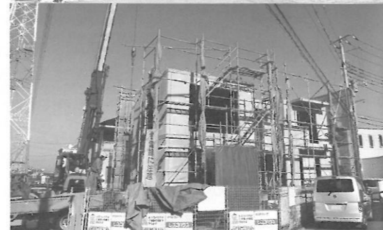
上/住宅展示場に建つレスコハウスのモデルハウス。下/レスコハウスの建て方作業中の現場
