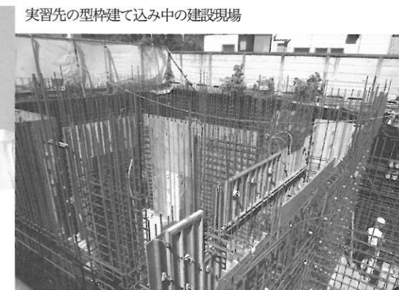
実習先の型枠建て込み中の建設現場
