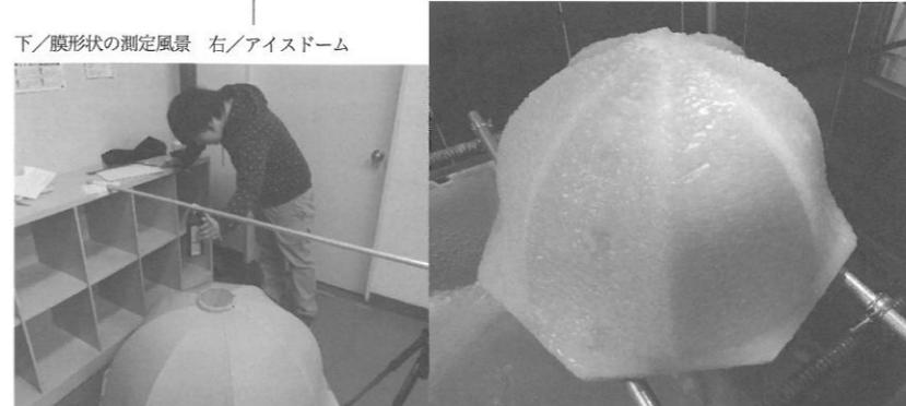
寒冷地における厳冬期のアクティビティの場として使用する、アイスドームを計画した。直径1mの半球ドーム形状の膜面は、球を8分割した布製のストリップを張り合わせてつくり、8つのライン下部に柔軟性のある直線状の曲げ材を挿入し、軸圧縮力で湾曲させることによりアーチ形状として、張力状態の膜曲面を形成した。氷点下20°Cの恒温室で、この膜表面に水を噴霧し凍らせることにより、アイスドームを制作した。その後、膜材・アーチを撤去し、アイスのみによるドームが完成した。
