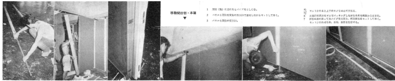
上/『連子』(1959年11月発行)に掲載された、5号館パーティションの組み立て工程。パイプの差し込み、間柱とパネルのセット、ネジ締めなどすべて手作業で行われた様子が紹介されている
