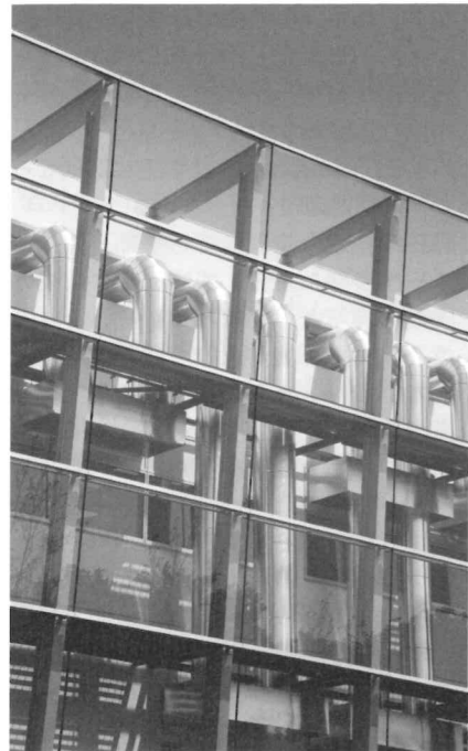
「大林組 技術研究所 材料化学実験棟」のメカニカル・バルコニー 設備設計担当・沼田和清
