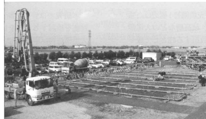
コンクリートポンプ工法の圧送実験の様子
