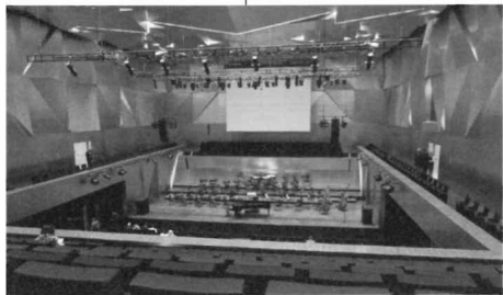
コンサートホールの壁面に設けた拡散体
