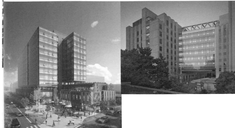
米国で関わったビルの建設プロジェクト。左はシアトルに建つアマゾン本社が入居予定の「Block 45」、右はシアトルに建つ総合病院の「Harborview Medical Center」
