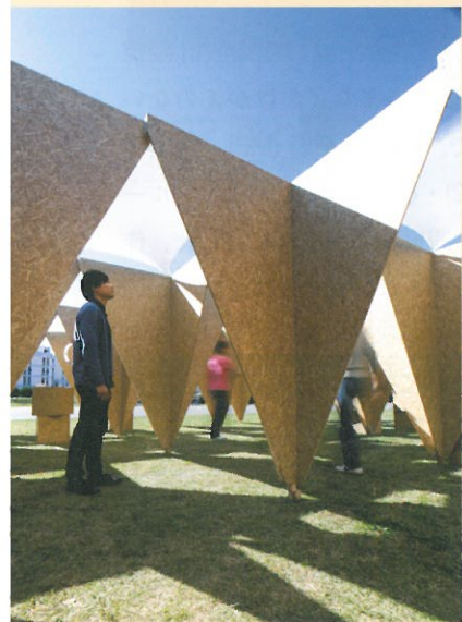
◀屋外に展示した、OSSB 麦わら成型合板を活用した自立型建築仕上げ材料。(写真/加藤雄生) ▲神奈川県の一色海岸に実際に建った、コンペで入選した海の家「カフェドロペラメール」(写真/大西正紀)
