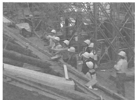
京都・知恩院の改修現場を視察
