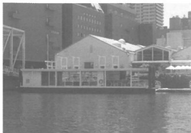
浮体式水上レストラン（手前ガラス張）
