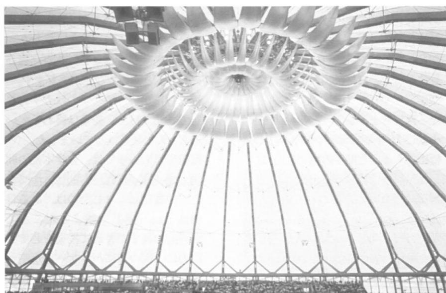
上／木造アーチとスリングでつくられる出雲ドームの立体張弦アーチ構造。デザインのイメージは「蛇の目傘」。1992年竣工。右／20分の1の実験模型。構造システムやディテール、施工法などの多様な検証が行われた
