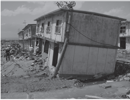
宮城県名取市閑上地区の被害調査。津波の遡上で基礎周りを洗掘されて傾斜した RC 造の集合住宅。周辺には漂流した漁船の衝突による建物被害も散見された
