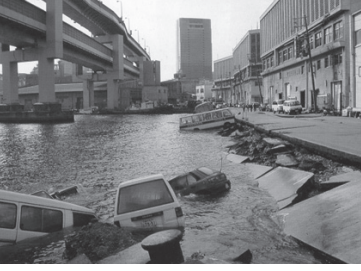
阪神・淡路大震災での神戸市中央区の港の被災現場
